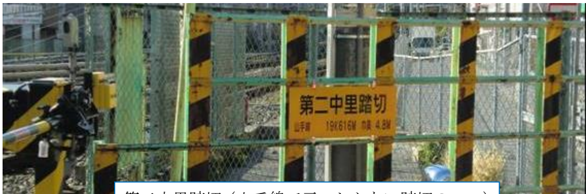
第二中里踏切（山手線で三つしかない踏切の一つ）
